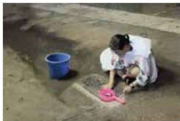
同工徒手清理渠口加速疏水
